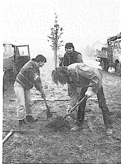
Abb.34 2. Markierung der Pflanzgrube, Abstechen des Oberbodens bzw. Rasensoden
