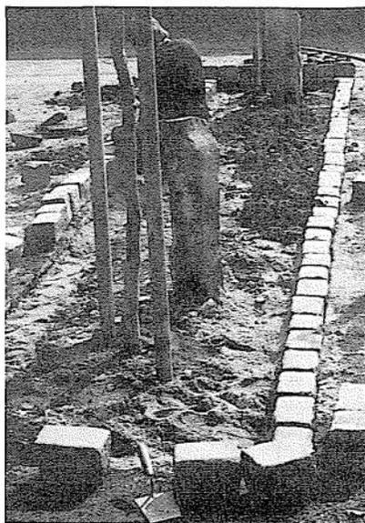
Abb. 18 Setzen der Läufer-
