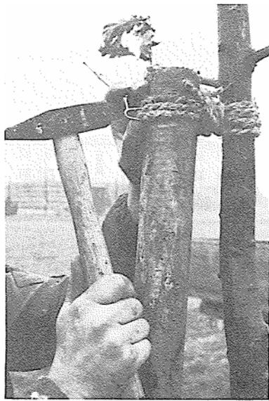
Abb. 59 27. Fixierung der Bindung am Pfahl mit Krampen
