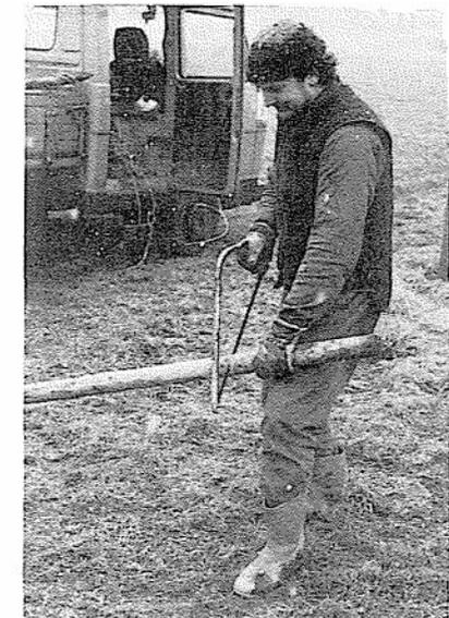
Abb. 40 8. Kürzung des Pfahls auf erforderliche Länge (Für Baumstärken bis 14/16 Stu genügt einfache Pfählung)
